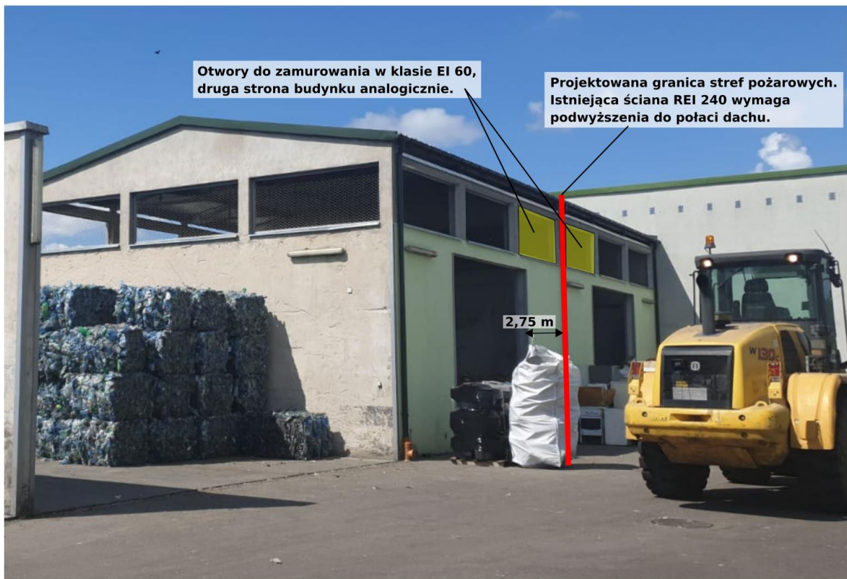
Rys. 5. Sposób oddzielenia stref pożarowych SP2 i SP3. Źródło: opracowanie własne.
